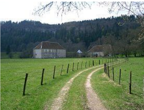
Bâtiments actuels à l'emplacement de l'ancienne abbaye de Balerne (Photo PRA – Wikipédia)
