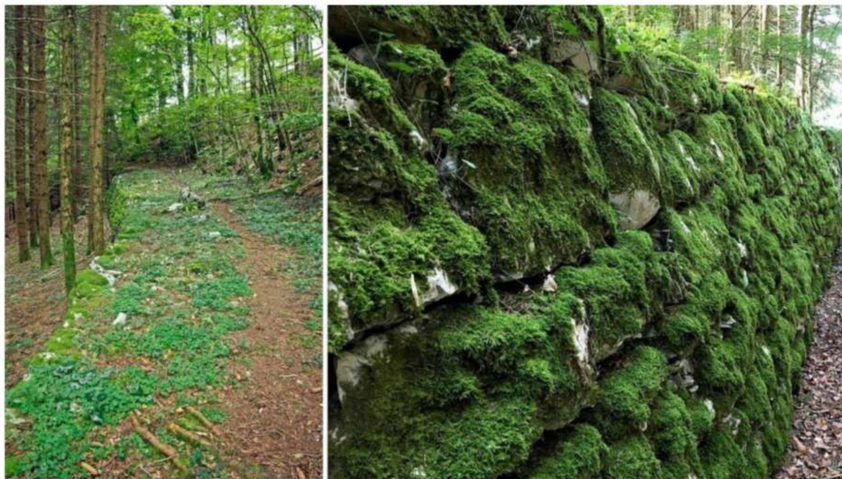
Une rampe d'accès à Chaux-des-Crotenay et son puissant mur appareillé. En bordure nord du plateau sommital de l'éperon de Chaux-des-Crotenay, une majestueuse rampe aménagée escalade la pente sous le plateau. Photo fournie par ArchéoJurasites
