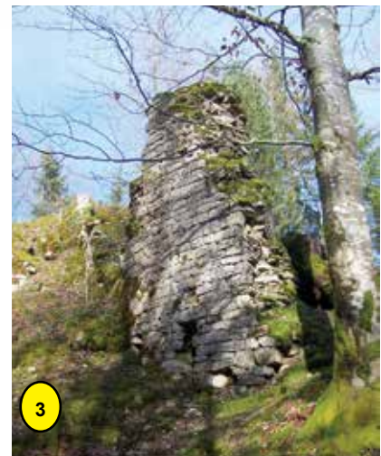
Tours nécessitant d'importants travaux de consolidation par une entreprise spécialisée
