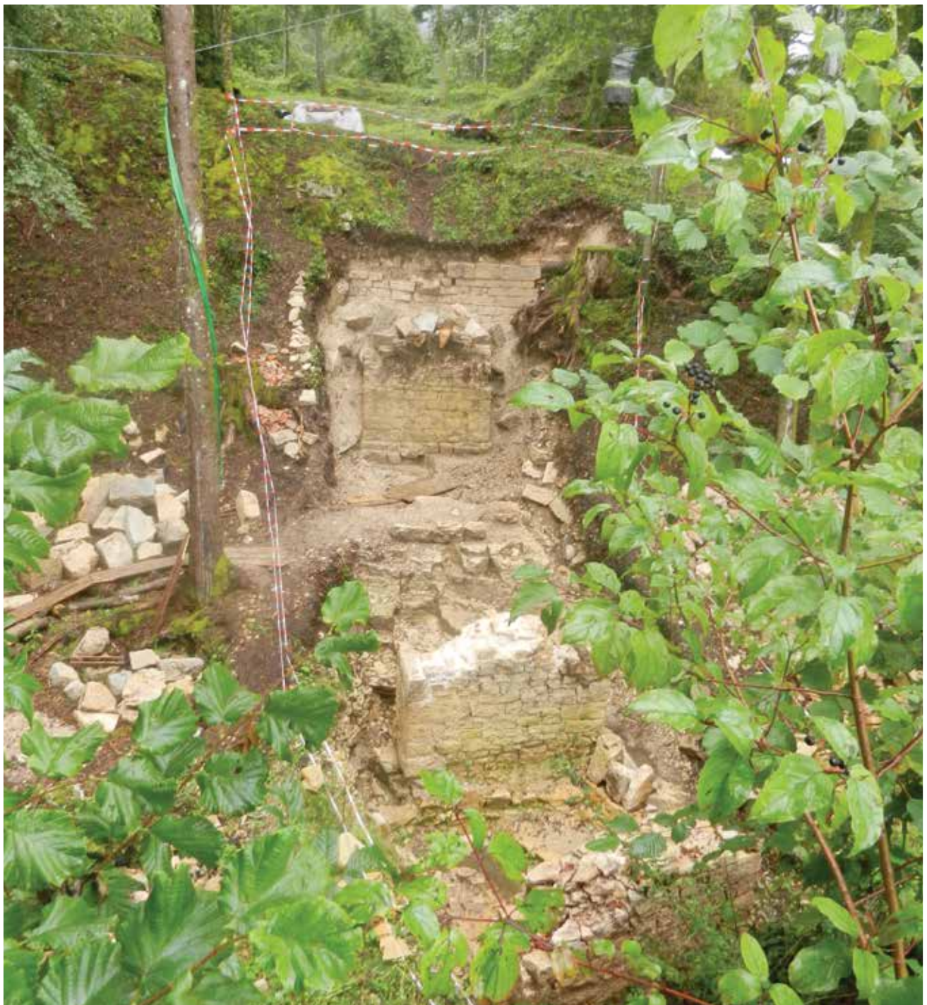
Deux années de travail ! Les quatre dernières piles puis le mur d'enceinte au fond.
