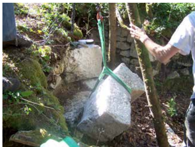
Dégagement de structures en pierre de taille et récupération de gros blocs éboulés
