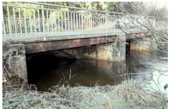
Le pont du Moulin du Milieu
