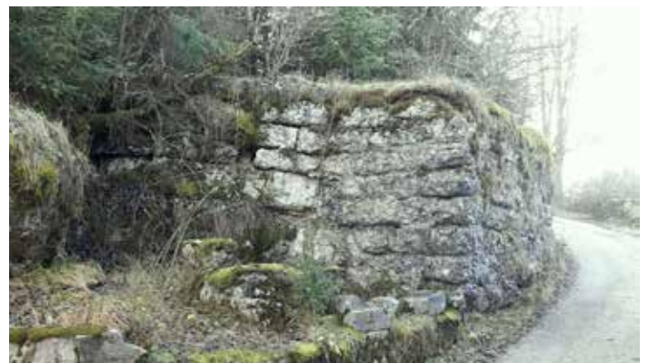
Vestiges de l'exploitation hydraulique (moulin du Milieu)
