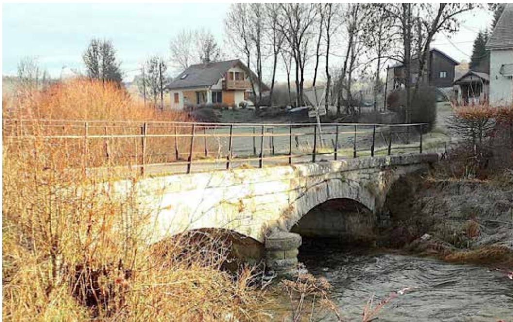
Le pont du hameau "Les Gros Louis"
