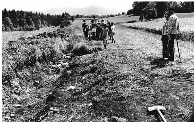
Vue d'ensemble de la tranchée de drainage de M. Tissot
