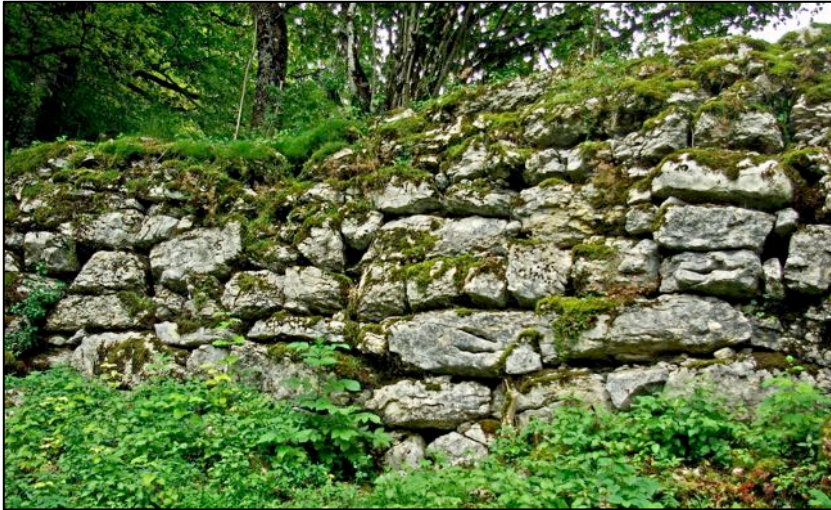
Tronçon A Mur du Chemin des ânes
