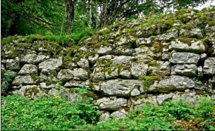
Tronçon A Mur du Chemin des ânes
